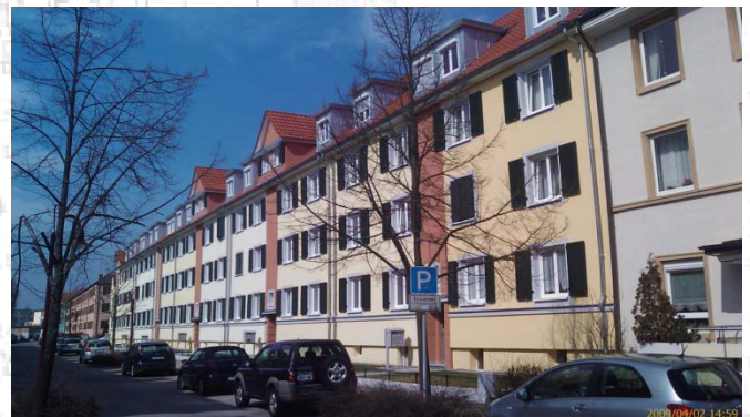
Vorderseite nach Sanierung
