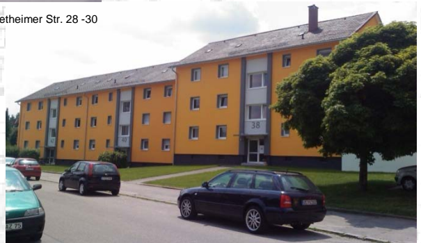
Straßenansicht nach Sanierung Rietheimer Str. 38-42
