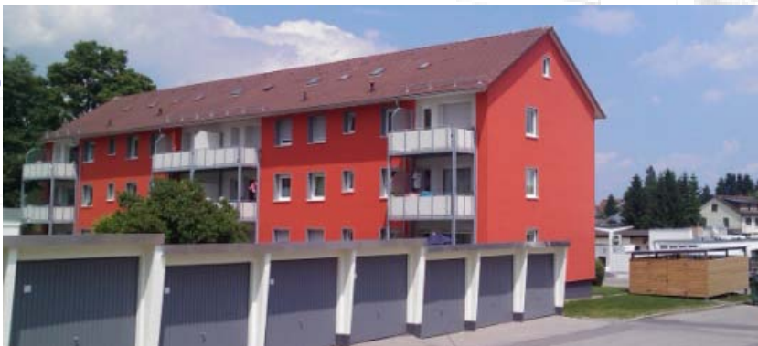
Hofansicht nach Sanierung Rietheimer Str. 28-30
