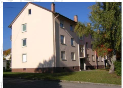
Straßenansicht vor Sanierung Rietheimer Str. 28-30
