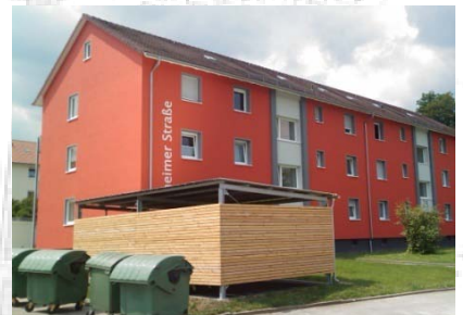
Straßenansicht nach Sanierung Rietheimer Str. 28-30
